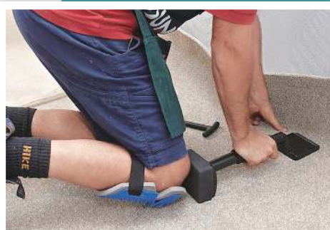
鋪地毯的技工工作時可以穿着保護裝置，避免重複跪地動作引致髕前滑囊炎。
